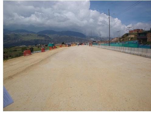
Se adelantan labores de conformación de bases y rellenos para pavimentación
