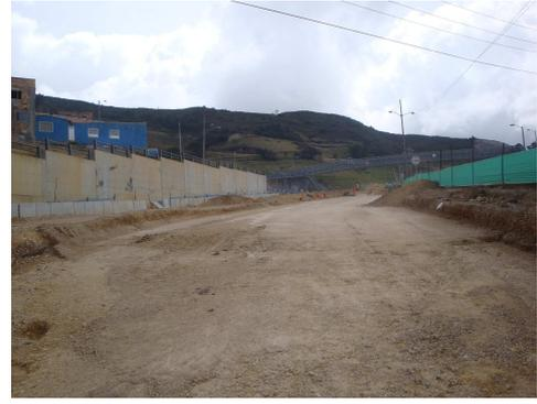
Se adelantan labores en conformación de espacio público, conformación de bases para pavimentación
