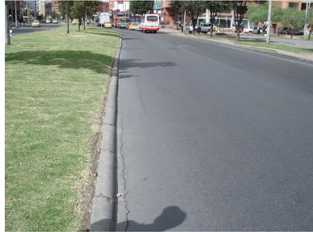
Fisuramiento longitudinal y transversal así como falta de confinamiento de la carpeta con el sardinel existente. Se evidencio falta de mantenimiento en sumideros y pozos y falta de señalización sobre los tramos ejecutados y algunos sectores con presencia de rodadura abierta.
