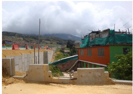
Obsérvese muros de contención construidos e instalación de redes para conformación de espacio público.
