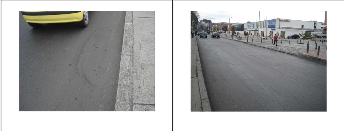
A la altura de Mc Donalds y Cafam de la Floresta se evidenciaron algunos hundimientos leves con aparentes apozamientos. Además de lo anterior se evidenciaron microfisuras transversales probablemente por compactación con exceso de temperatura en una longitud aproximada de 30 metros.
