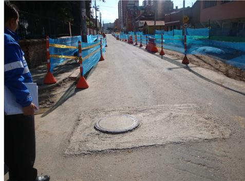
Obsérvese vía a nivel de base asfáltica. Pendiente por ejecutar sobrecarpeta en rodadura. Se evidencia presencia de algunos apozamientos.
