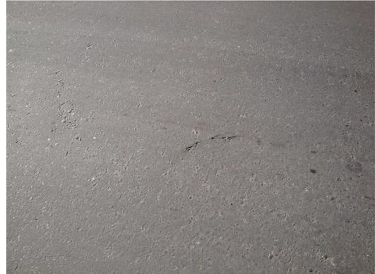
Se evidencia a la fecha, 26 de octubre de 2009, incipiente deterioro sobre la carpeta del pavimento representado en una falla por desprendimiento a manera de ojo de pez y otra falla por fisuras transversales leves.
