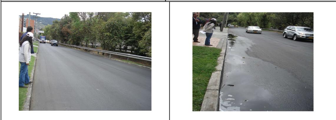
Se evidencian apozamientos frente a placa No. 12B-30 y pozos desnivelados frente a placa 12B-04.
